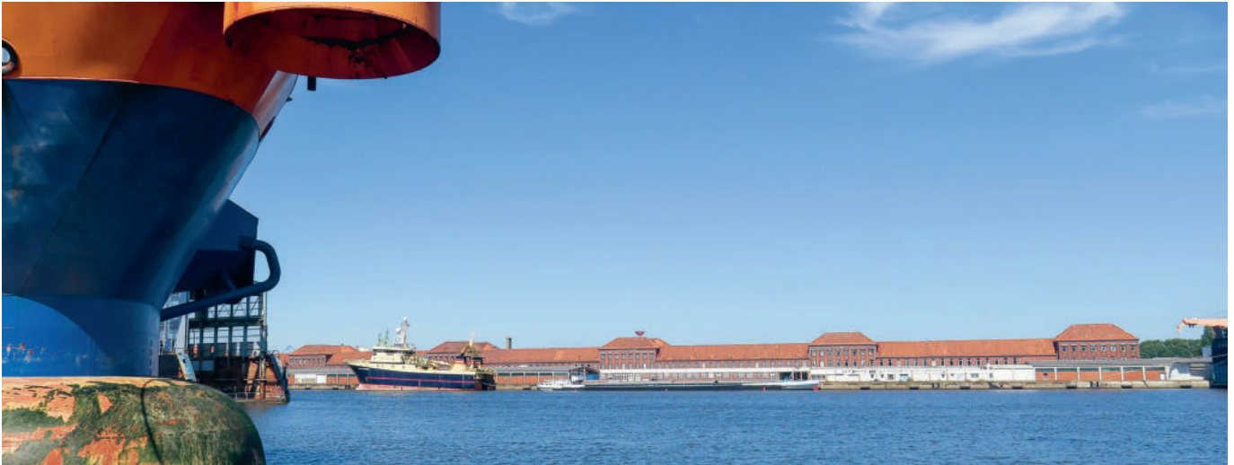
Die historische Fischauktionshalle X im Fischereihafen wird in Teilen zu einem Startup- und Innovationshub für die Fisch- und Lebensmittelwirtschaft ausgebaut. Foto: FBG / Martina Buchholz
