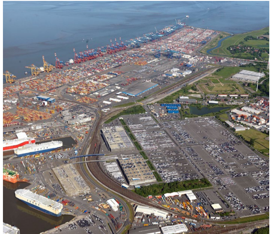
Die Hafenmanagementgesellschaft bremenports kümmert sich in den Bremerhavener Häfen um mehr als 21 Quadratkilometer Land- und Wasserfläche. Die Erkenntnisse des Projekts PortKLIMA fließen in die kontinuierliche Hafenentwicklung mit ein. Foto: Wolfhard Scheer / bremenports GmbH & Co. KG
