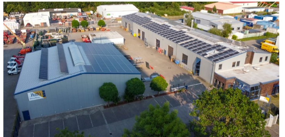
Insgesamt rund 2.200 Quadratmeter Solarpanels hat die Firma Huth auf den Dächern ihrer Gebäude installiert. Foto: Huth
