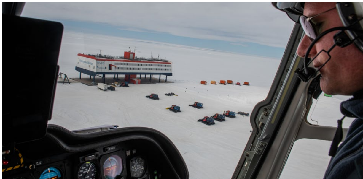
Im Anflug auf die Neumayer-Station III in der Antarktis. In dem komplexen Bauwerk steckt auch viel Expertise Bremerhavener Firmen. Foto: AWI / Esther Horvath
